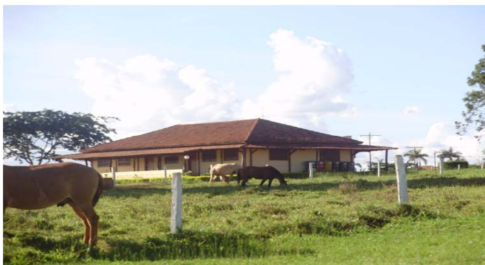
FIGURA 1: Infraestrutura externa da escola.
